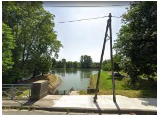
Déversoir du Canal de Montech dans le Tarn à Montauban
