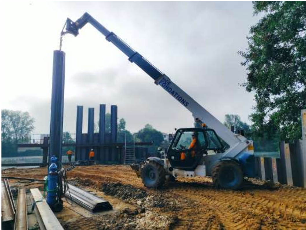
Figure 4 : Pose des palplanches en cours de réalisation (opérations préalables sur l'écluse de Sapiacou 2023)
