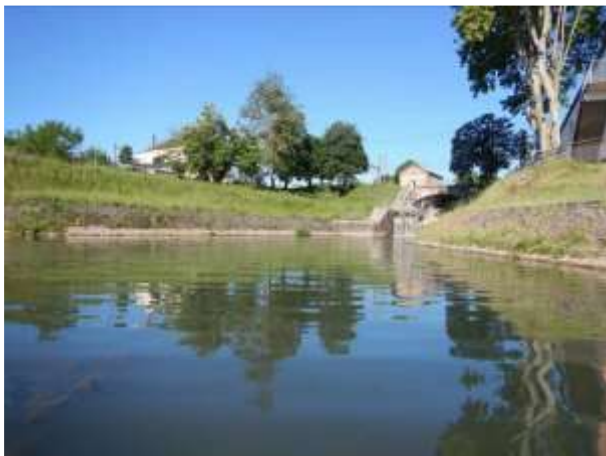
Secteur de l'écluse du canal de Montech
