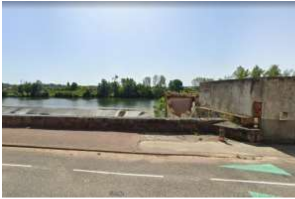
Rive gauche - Vue du Moulin et du seuil
