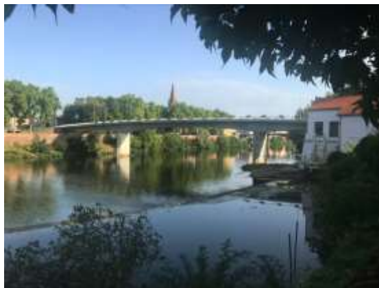
Centrale hydroélectrique EDF au droit de la chaussée de Sapiacou
