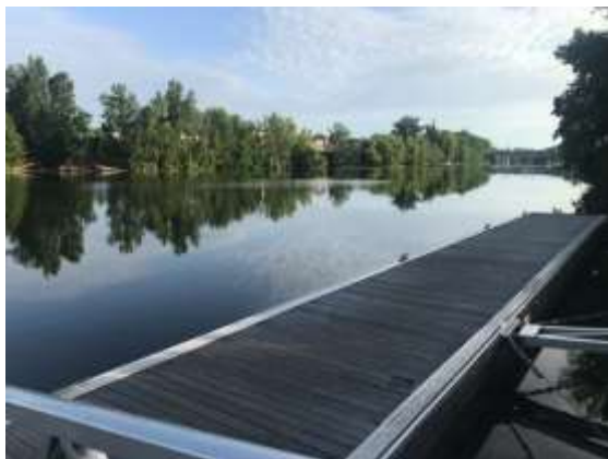
Ponton flottant en partie médiane du linéaire
