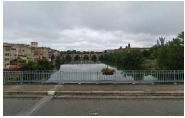
Vue du Pont Neuf vers l'aval - Contexte urbain RG et Zones de verdure en RD
